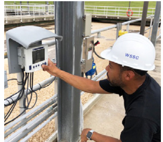
Abbildung 9: Greg Whitley an der Seneca Kläranlage unter Verwendung des IQ SENSOR NET-System.
