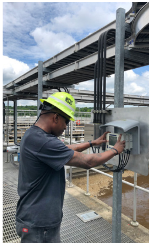
Abbildung 6: In der Western Branch überprüft Lydell Washington Echtzeit-Nährstoffmessungen auf dem IQSN 2020 3G-Steuergerät.
