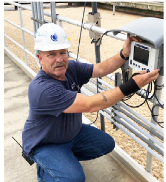
Abbildung 1: Marty Johnson, leitender Anlagenbetreiber der Seneca-Abwasseraufbereitungsanlage in Washington, D.C.
